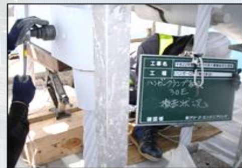
ハンガークランプ撤去状況
