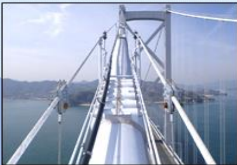
ゴンドラ吊元設置
