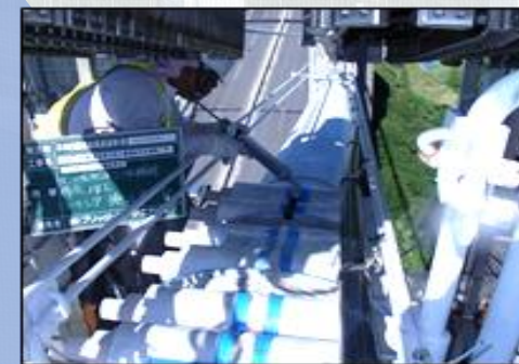
ケーブルバンドシール設置
