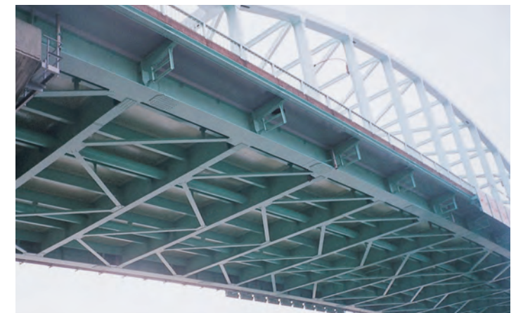
入江大橋橋梁補修工事
