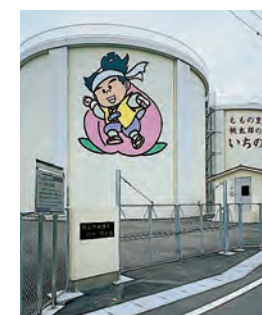
岡山市水道局西辛川配水場
