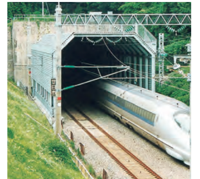
新幹線緩衝工事
