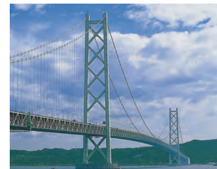
明石海峡大橋
