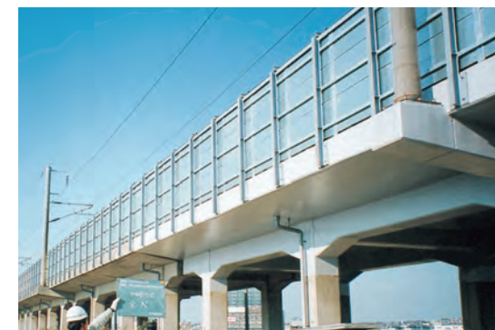
新幹線防音壁工事
