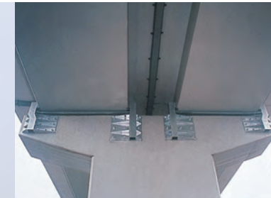
新幹線桁移動防止工事
