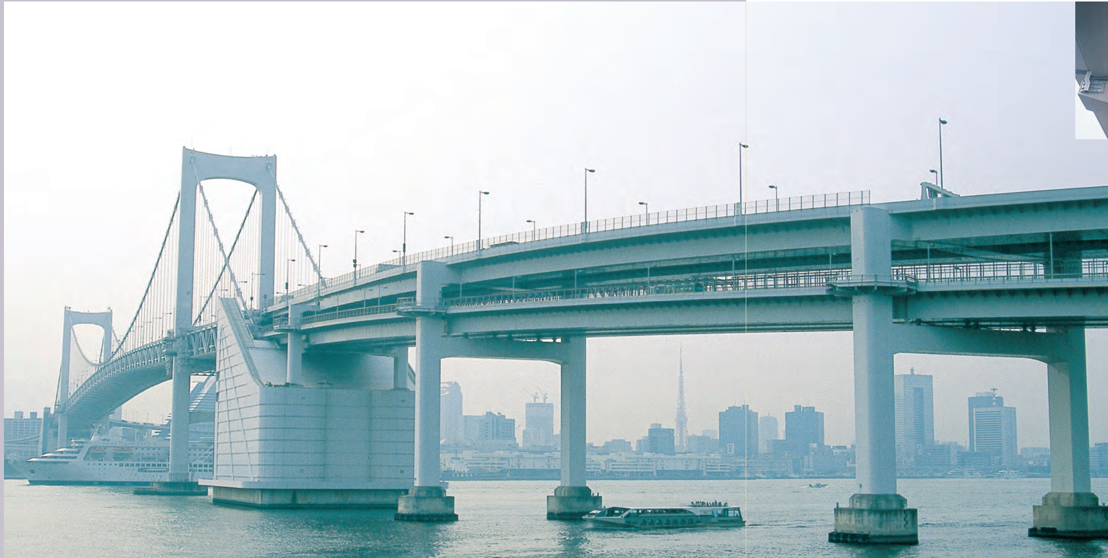
首都高速橋梁耐震工事
