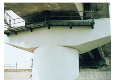
耐震補強工事
