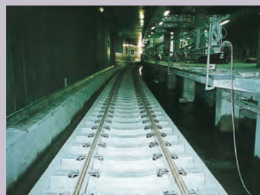
レール敷設工事
