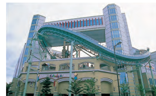
フェスティバルゲート立体駐車場
