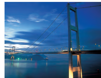
来島海峡大橋
