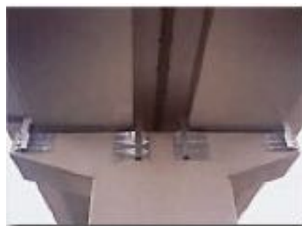
新幹線桁移動防止工事
