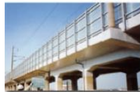
新幹線防音壁工事
