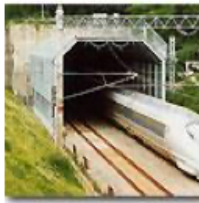
新幹線緩衝工工事
