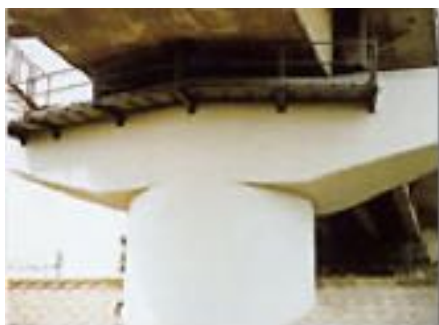
耐震補強工事
