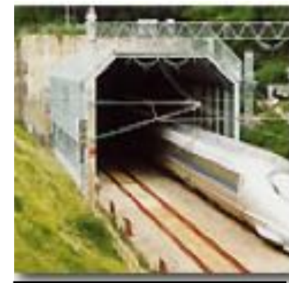
新幹線緩衝工工事
