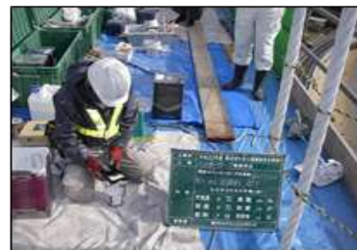
①-⑤ 塗料粘度測定状況
