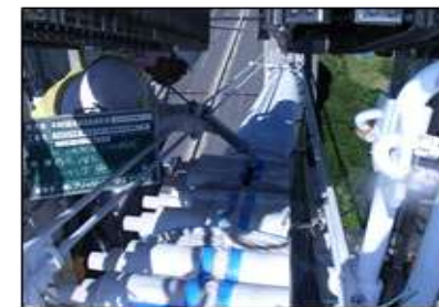
④ケーブルバンドシール設置
