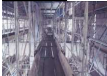
高架橋足場内部
