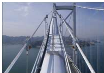
①-① ゴンドラ吊元設置状況
