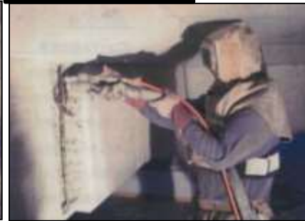
鉄筋ケレン作業
