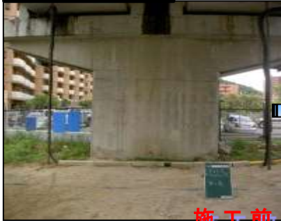
耐震補強工事
