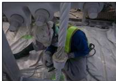
③ケーブル作業車での作業
