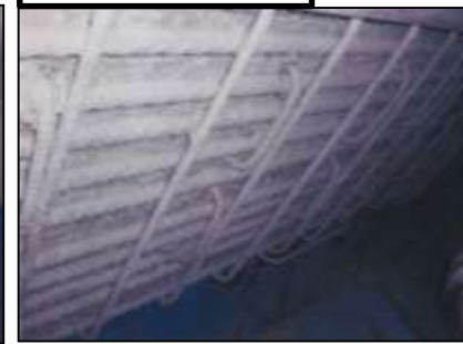
防錆材の塗装
