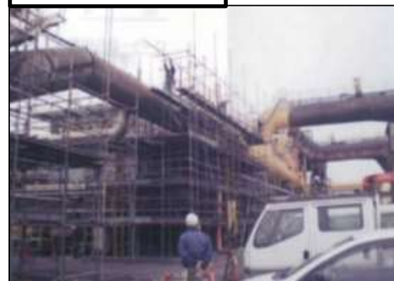
足場の組立・解体
