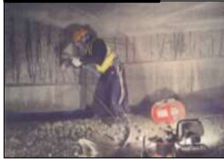
コンクリート補修
